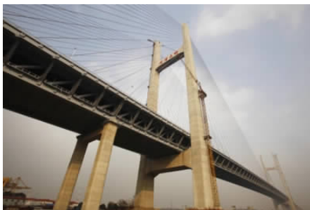
图20 闵浦大桥全景(图片来源:裴鑫摄)
