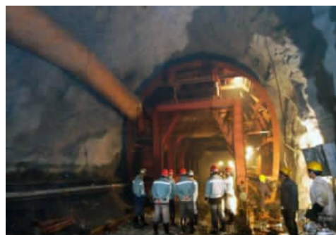
图 16 大伙房水库输水一期工程输水隧道贯通 (图片来源:新华社)
