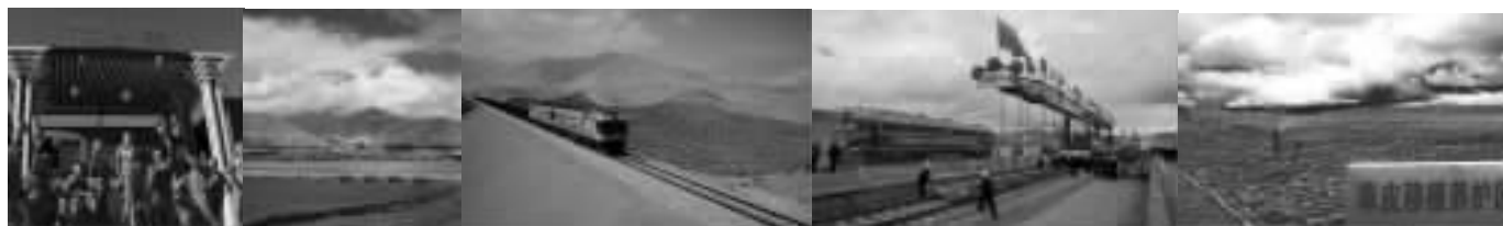
欢庆铺轨完工
