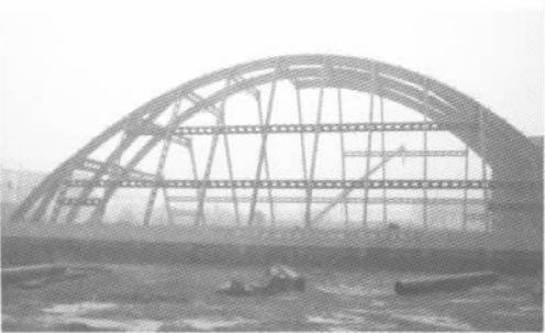
图9 采用 WGJ510C2 钢建成的上海中国残疾人体育艺术培训基地建筑网架
