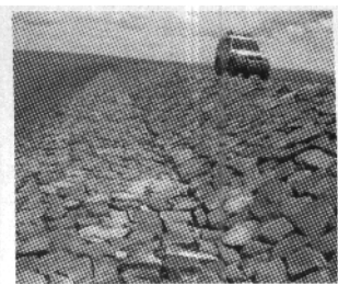
图2 块石护坡路基结构
