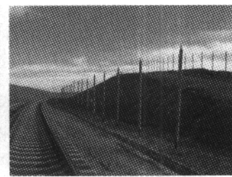
图4 热棒路基结构
