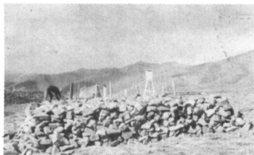
图3 青海热水块石路堤试验(1973年)
