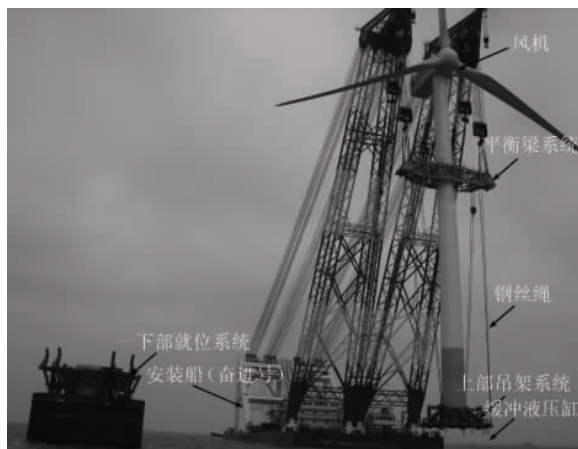
图 1 风机软着陆安装体系
