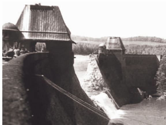
图 3 1943 年 5 月 17 日德国 Möhne 大坝受炸弹袭击溃决 Fig. 3 Möhne Dam break (Germany, 17 May 1943), after RAF bomber attack—view from right bank (source: Chanson, 2005)
