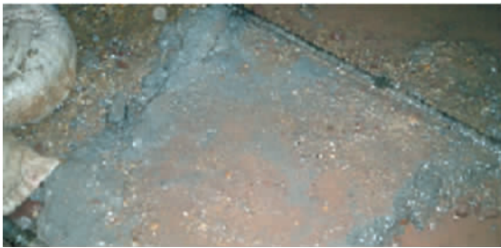
图 3 桩短桩抗压摩阻力破坏
