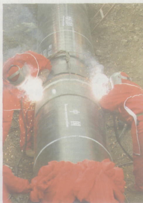
图15 中哈石油管道对接
