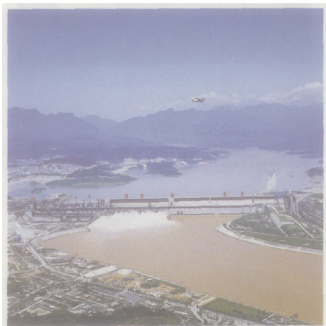
图14 三峡大坝全貌
