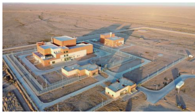
戈壁滩上的钍基熔盐实验堆园区
