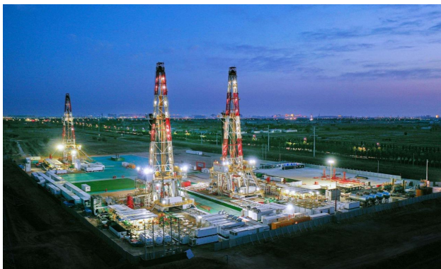
图25 胜利济阳页岩油国家级示范区钻井施工现场 (图片来源:中国石油化工集团有限公司)
