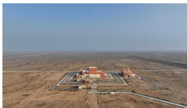
图 20 甘肃省民勤县航拍的 2 MW 液态燃料钍基熔盐实验堆厂房
