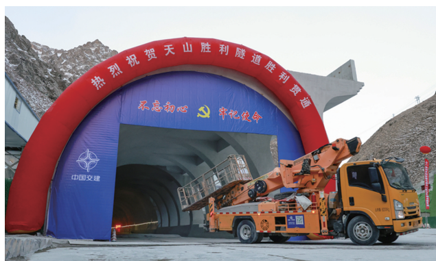
图30 天山胜利隧道贯通 (图片来源:新华社)
