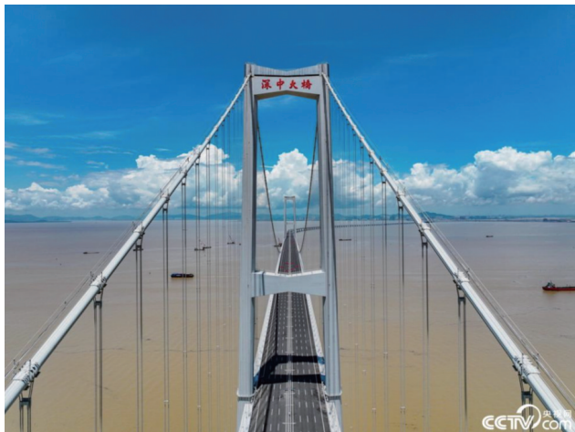
图24 深中大桥整体景象 (图片来源:央视网)
