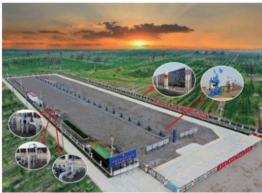
图 5 大港港西 2 号电潜螺杆泵大平台
