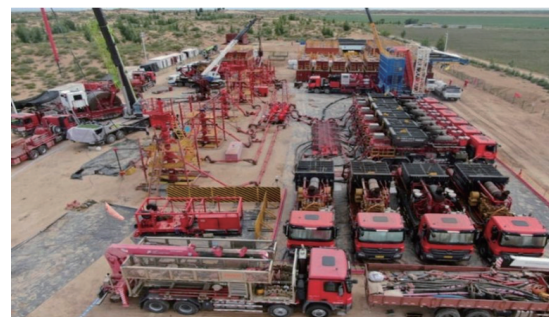
图 19 酸化压裂过程中地面管汇装置
