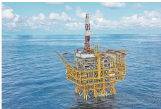
图1 “海基一号”深水导管架(陆丰15-1)
