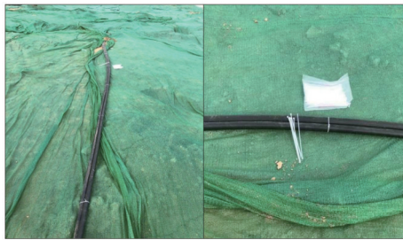
图2 地埋管固定现场
