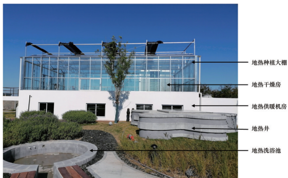
图9 小洋口温泉展示中心地热综合利用系统外部实景
