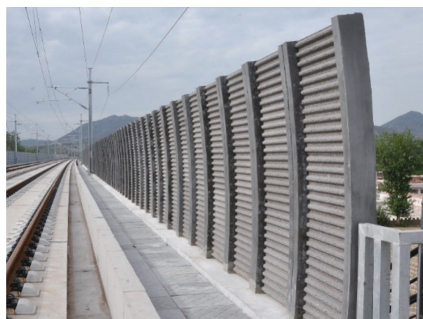
图8 超高强混凝土-微孔陶粒声屏障
