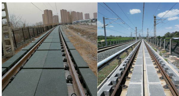
(a) 聚合微粒轨道吸声板 (b) 泡沫铝轨道吸声板
