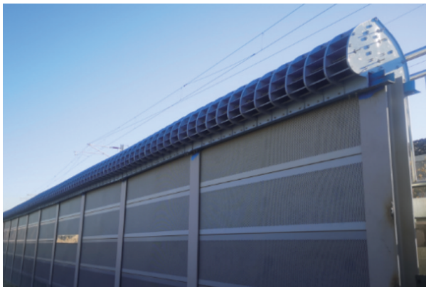
图9 声屏障顶端降噪器
