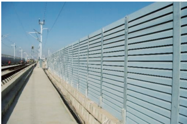
图6 减载式声屏障
