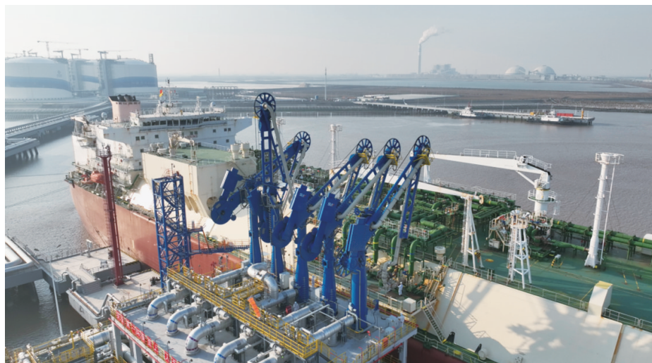
图22 自主研发的LNG卸料臂进行首船接卸作业
