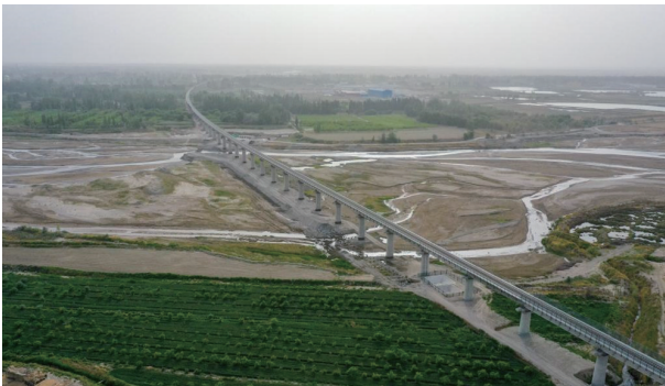
图25 和若铁路车尔臣河特大桥 (图片来源:新华社)
