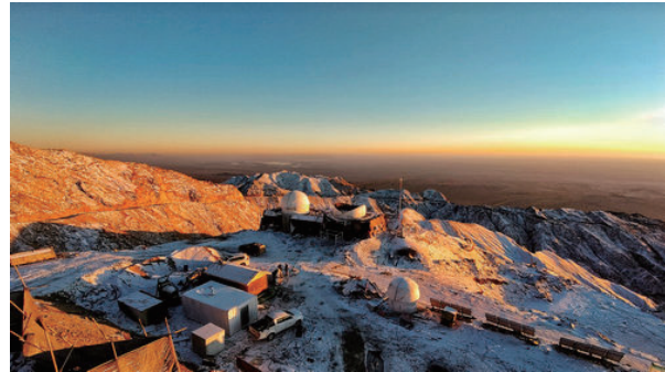
图8 赛什腾基地C区建设实景
