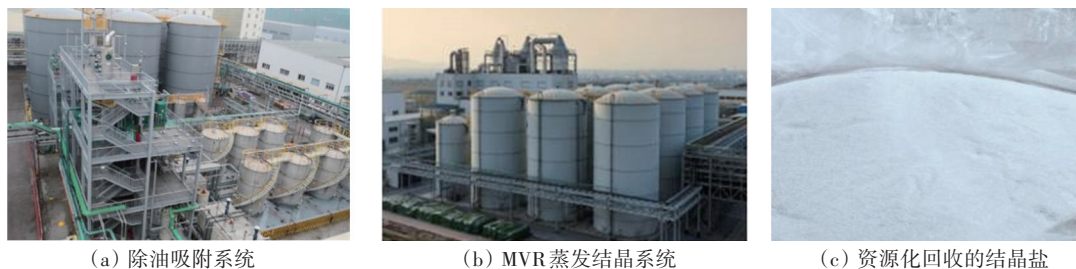
图7 无机精细化工高盐有机废水有价值组分回收与水资源回用技术的工程应用
