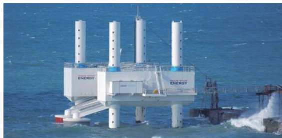
图11 Wavestar装置1:2比例样机海试
