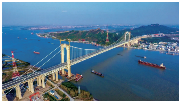
图28 五峰长江大桥(图片来源:中铁大桥局集团)
