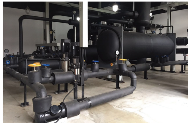
图8 10 kW 海洋温差能实验装置
