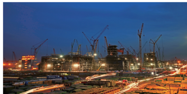
图16 青岛海工建造场地“亚马尔”模块建造现场
