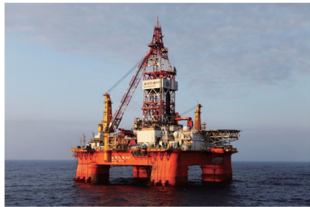
图3 超深水半潜式钻井平台“海洋石油981”
