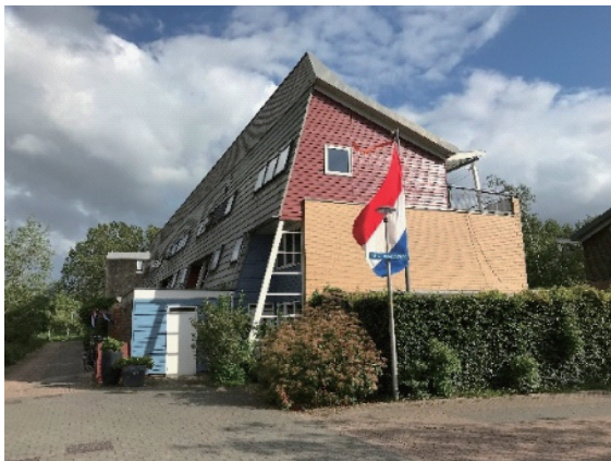
图9 雨水通过屋面排入可渗透草地
