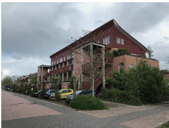
图10 停车地面采用可渗透铺装
