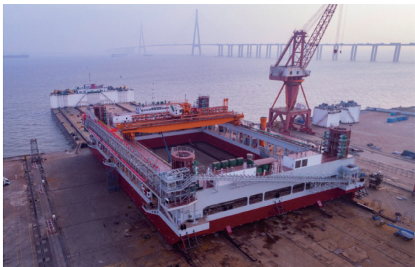
图28 在建中的自升式碎石铺设整平船“一航津平2”
