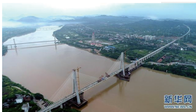
图29 昌赣高铁赣江特大桥合龙 (图片来源:新华网)
