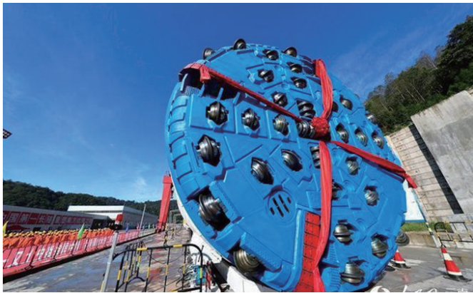
图5 用于中国铁路第一长隧——高黎贡山隧道施工的国产再制造TBM(图片来源:中铁隧道股份有限公司)
