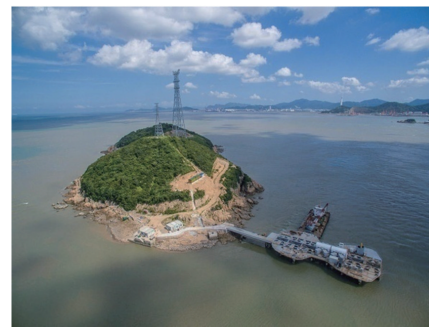
图2 “LHD”模块化大型海洋潮流能发电机组 Fig. 2 “LHD” Modular large tide energy generator
