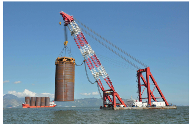
图5 港珠澳大桥人工岛筑岛钢圆筒
