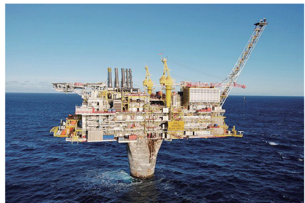
图6 挪威 Draugen 海湾海上平台
