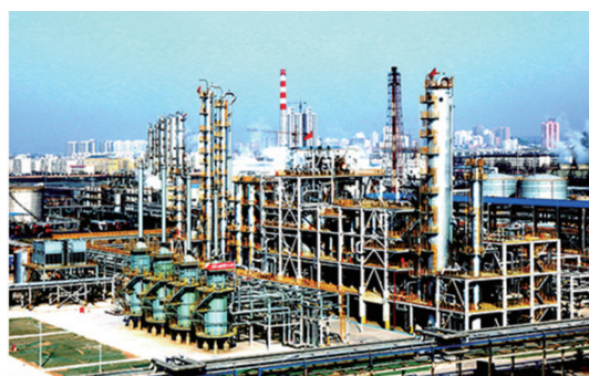
图22 延长石油10万吨/年合成气制乙醇装置 (图片来源:中国科学院网站)
