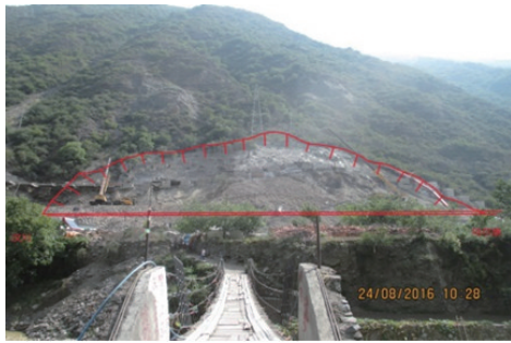
图1 碎石土边坡滑坡全貌
