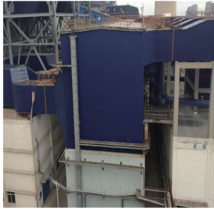
图1 原布袋除尘器现场照片 Fig. 1 Bag-filter photo
