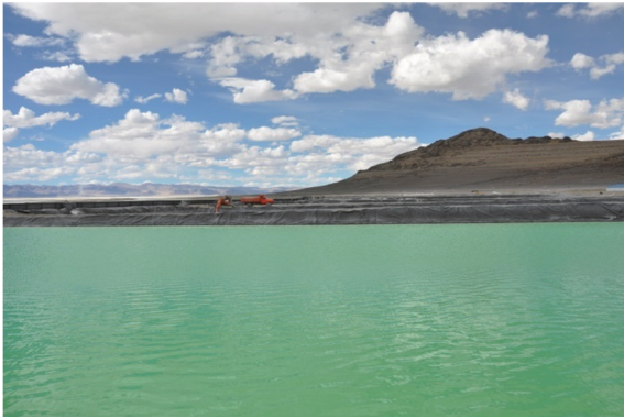
图3 正在运行中的扎布耶盐湖结晶池
