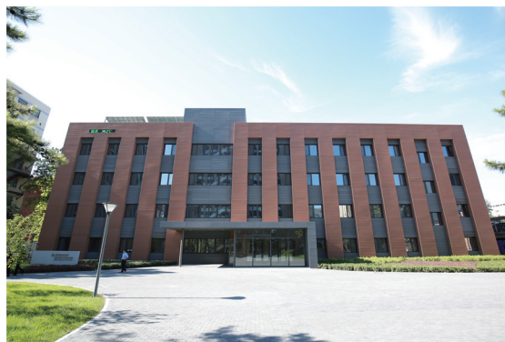
图1 中国建筑科学研究院近零能耗示范建筑
