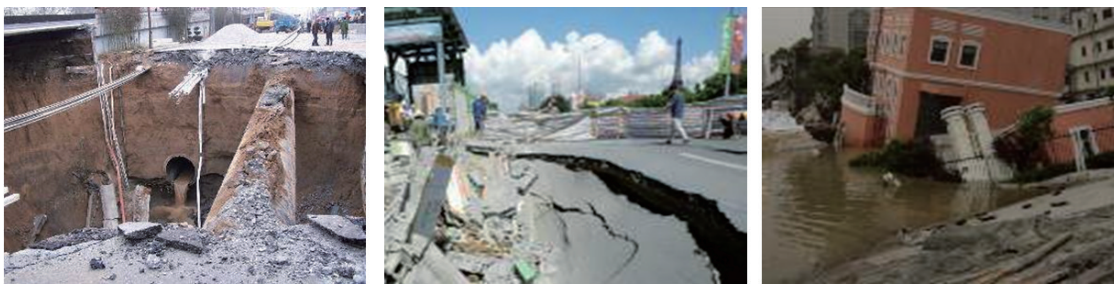
(a) 北京京广桥邻近地面塌陷
