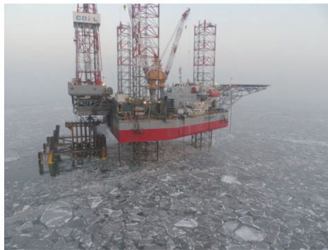
(a) 渤海冰区自升式海洋平台
