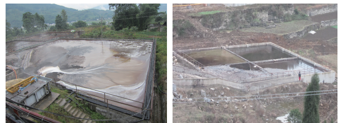
(a) 川南宁201平台的沉砂池 (b) 重庆涪陵焦石坝48平台的储污池
