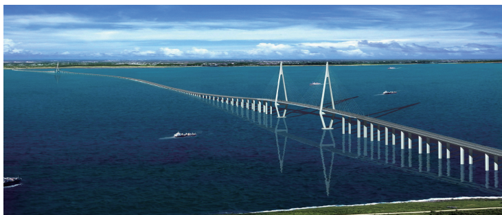
(b) 杭州湾跨海大桥
