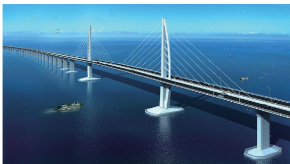
(c) 港珠澳大桥
