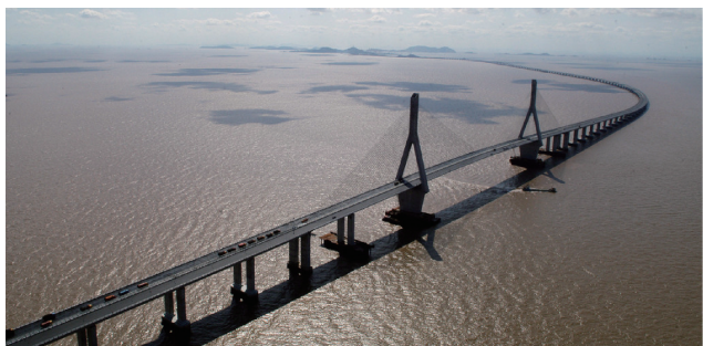
(a) 东海大桥
