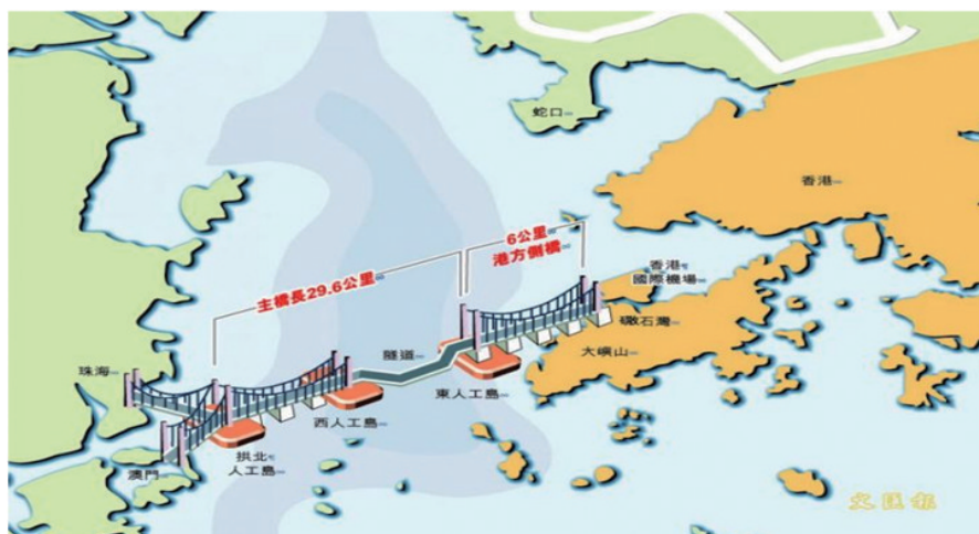
图1 港珠澳大桥工程概况
