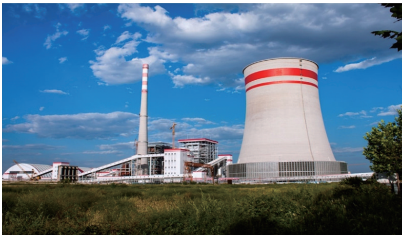
图3 山西国金电力公司 2×350 MW 低热值煤超临界循环流化床锅炉热电厂超洁净排放现场实景
