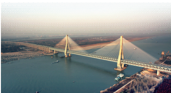
图3 武汉天兴洲长江大桥
