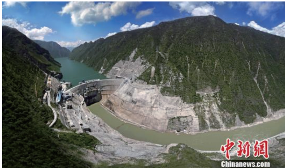
图20 世界最高拱坝——锦屏一级水电站大坝(图片来源:中国新闻网)
