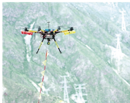
图19 国家电网的遥控飞机在四川巴塘县进行空中架线(图片来源:新华社)
