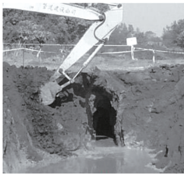
图9 多级扩孔后形成的长圆孔
