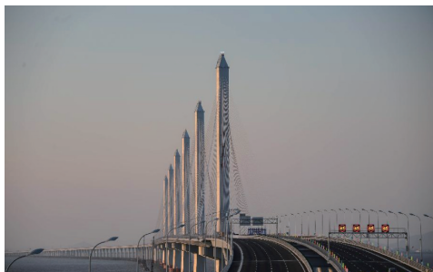
图13 竣工的嘉绍跨海大桥(图片来源:新华网)
