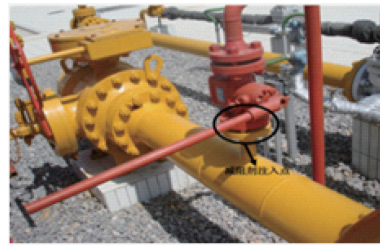
图12 减阻剂注入点位置
