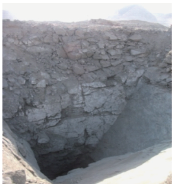
图 4 深孔爆破一次成井效果
